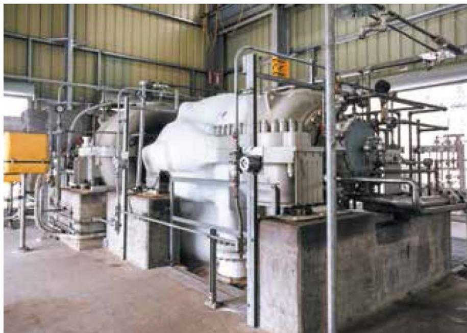
Figura 2.9: Foto de um compressor de etileno refrigerante (Harvey, 2017).
