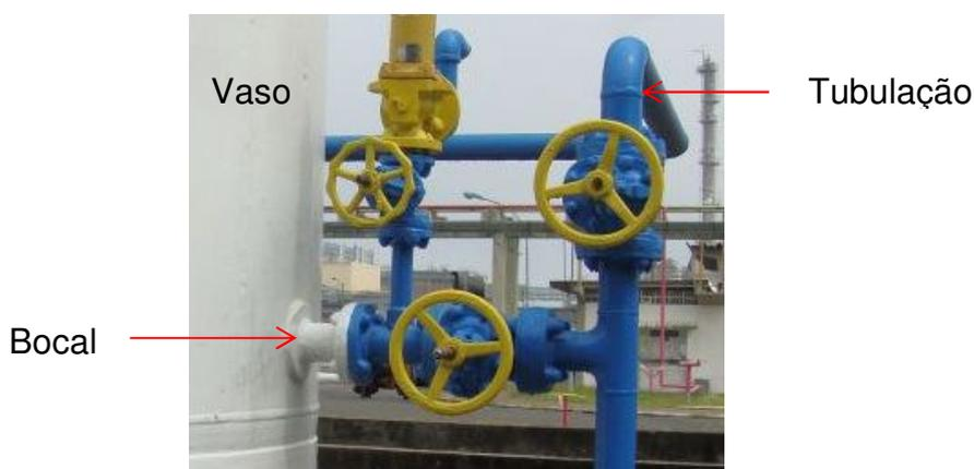
**Figura 2 – Exemplo de bocal conectado à tubulação**
