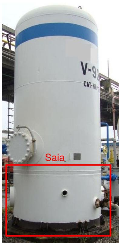
Figura 8 – Vaso de pressão vertical suportado por saia
