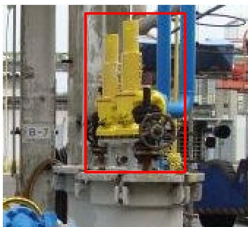
**Figura 10 – Bocais com válvula de alívio**
