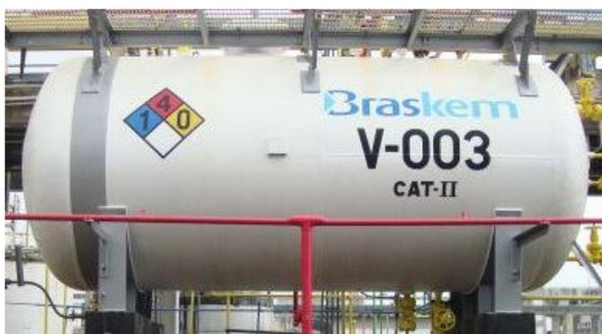
**Figura 4 – Vaso de pressão cilíndrico horizontal com tampos torisféricos**
