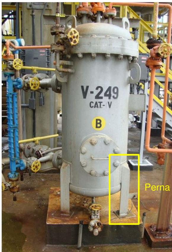
Figura 7 – Vaso de pressão vertical suportado por pernas
