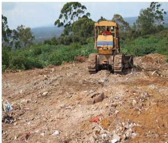
*Figura 3 - Preenchimento de Solos Degradados com RCC.
