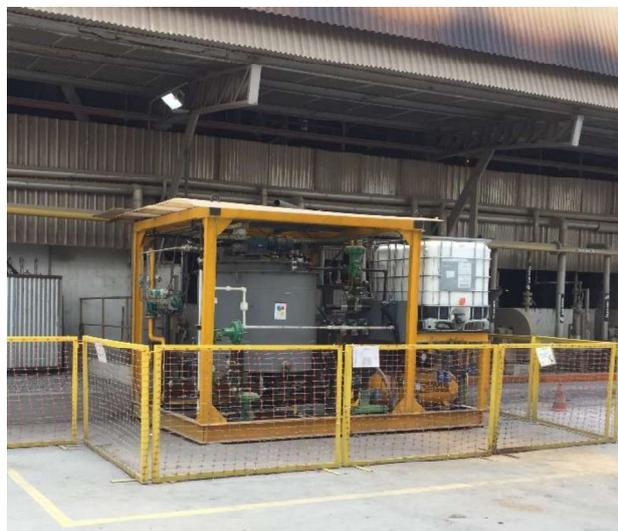
O aparato integrado ao forno de produção de óxido de zinco, possui sistema de controle e monitoramento das variáveis de processo (temperatura e vazão) do ar de combustão, combustível e gases exaustos. Os dados dos experimentos foram acompanhados através da tela de Interface Homem Máquina (IHM), conforme Figura 12. Para cada teste realizado foi configurada uma tela gráfica específica de forma
