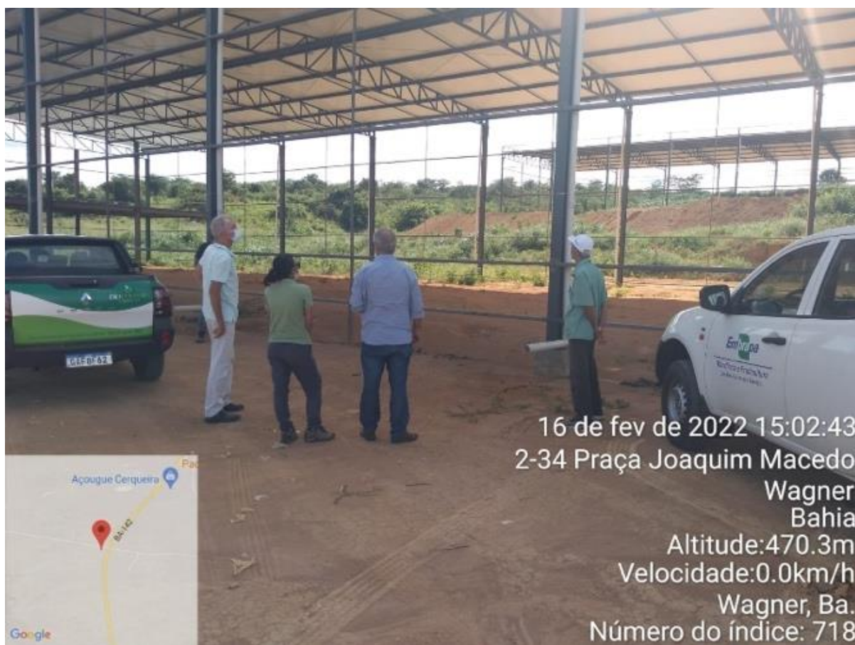
Figura 18. Galpões para abrigar as futuras instalações do Empreendimento BIOFAL, Wagner – BA. Obras sendo validadas pelos técnicos da Embrapa. Fonte: Produção própria, 2022.
