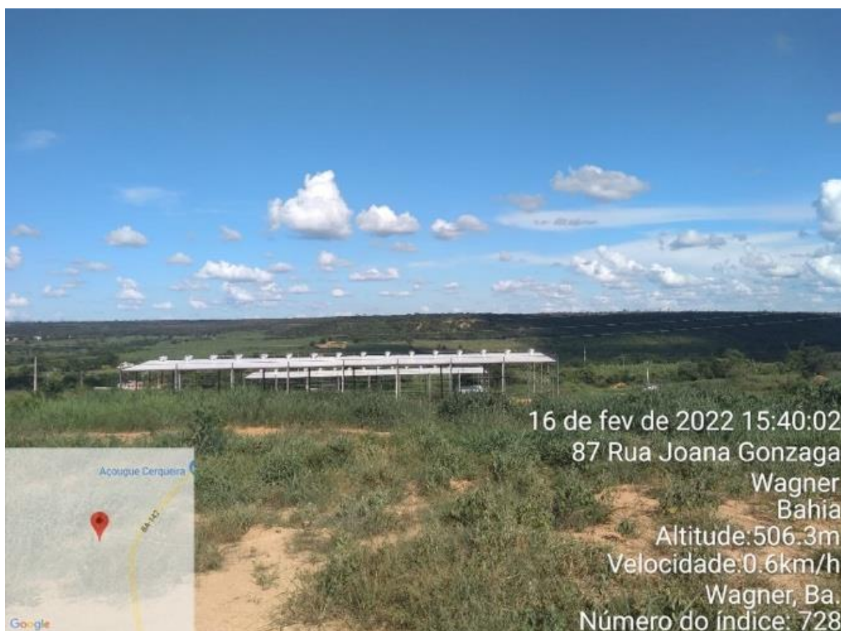
Figura 17. Galpões para abrigar as futuras instalações do Empreendimento BIOFAL, Wagner – BA. Obras sendo validadas pelos técnicos da Embrapa. Fonte: Produção própria, 2022.
