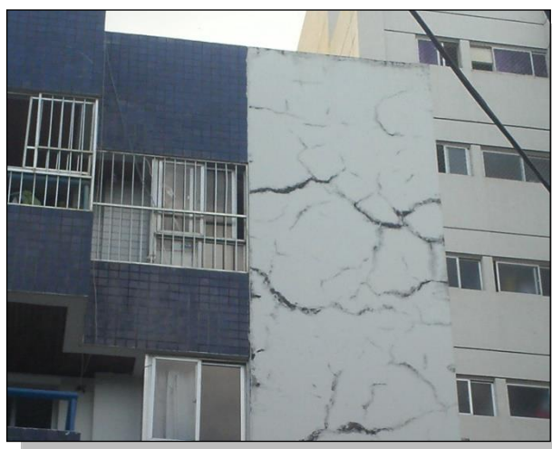
Figura 3 – Fissuras superficiais.
