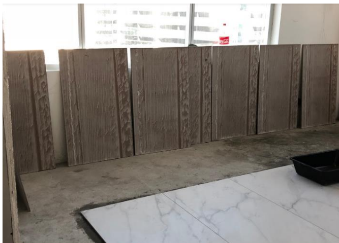
Figura 4: Separação das peças para assentamento
