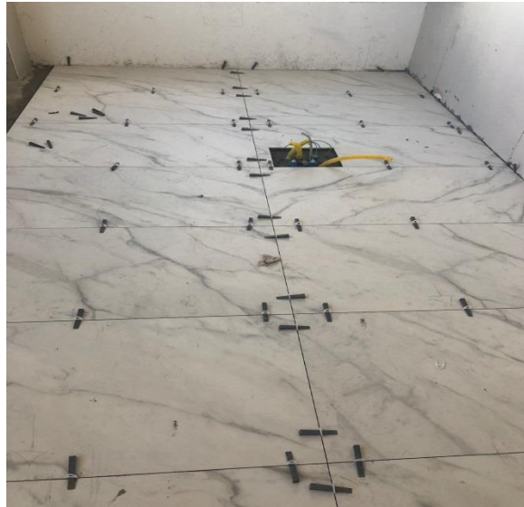
Figura 6 – Utilização de cunhas niveladoras de piso
