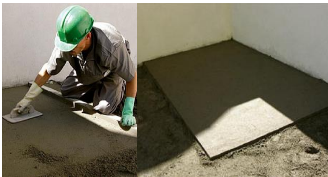
Figuras 02 e 03: Execução de Contrapiso Convencional
