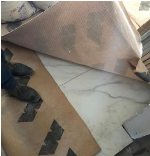
Figura 9 – Proteção de piso cerâmico com papelão ondulado
