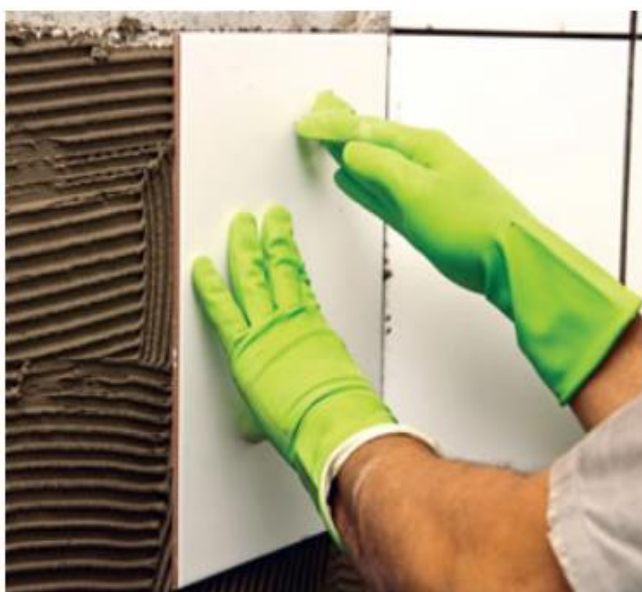
Figura 01: Execução de Assentamento Cerâmico
