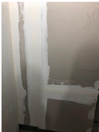
Figura 3: Tratamento das juntas e cabeça dos parafusos
