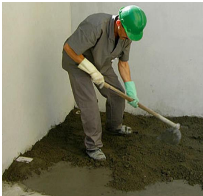
Figura 4 – Espalhamento do Contrapiso
