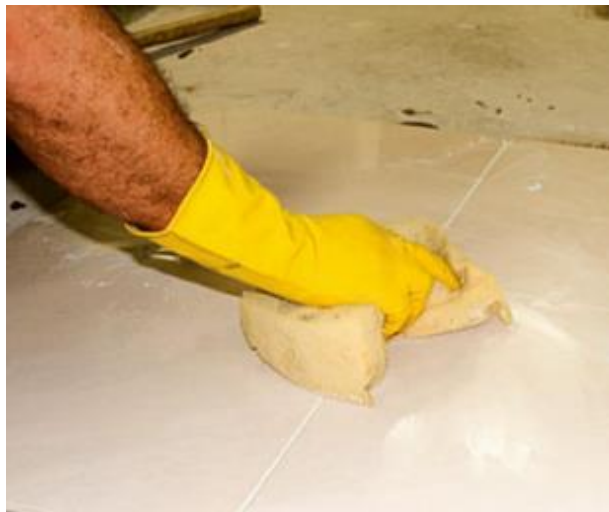
Figura 8 – Limpeza do excesso com pano úmido Fonte: Construção Passo-a-Passo, 2009, p.102
