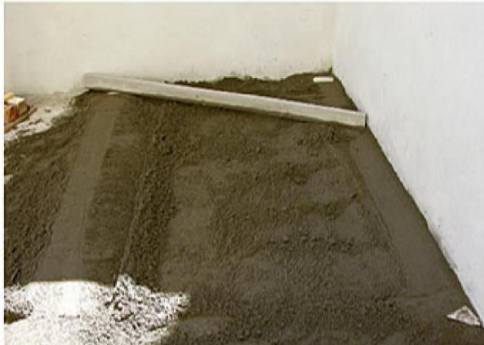
Figura 3 – Execução das Mestras
