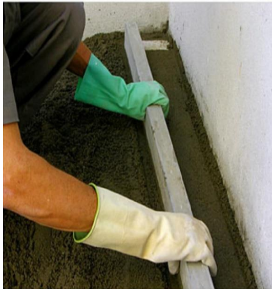
Figura 6 – Sarrafeamento do contrapiso
