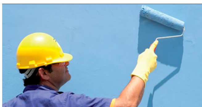
Figura 04: Execução de Pintura Interna
