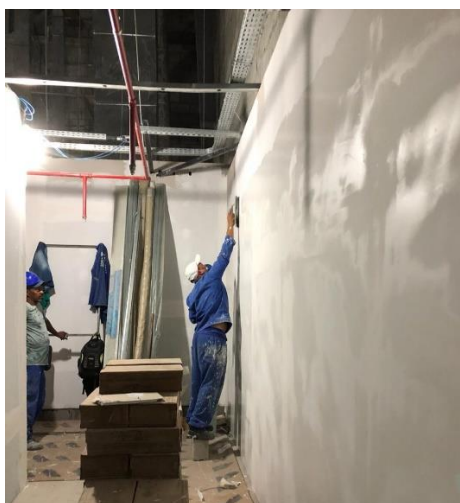
Figura 5: Aplicação da massa corrida
