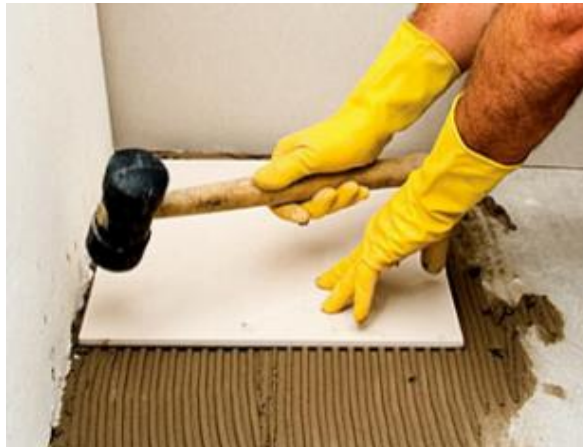
Figura 4 – Utilização do martelo de borracha Fonte: Construção Passo-a-Passo, 2009, p.99
