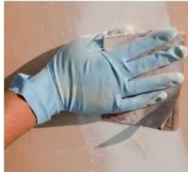
Figura 1 – Lixamento da parede
