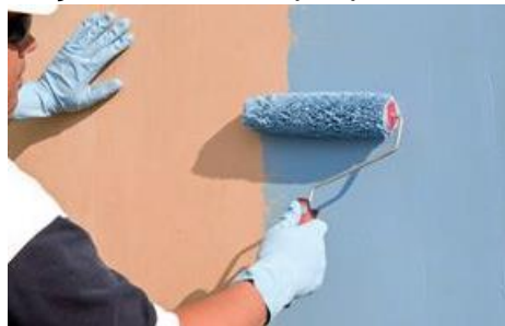
Figura 2 – Pintura da parede
