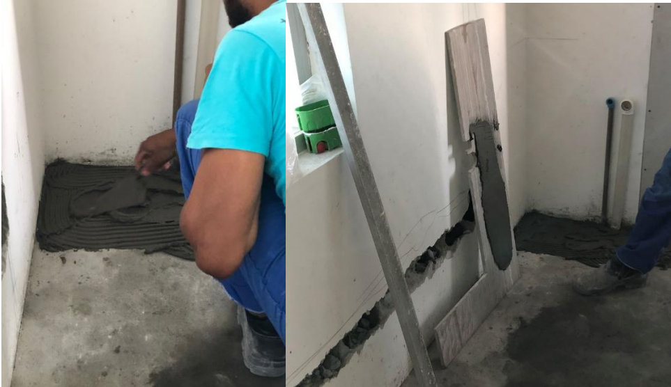
Figuras 6 e 7: Aplicação da argamassa colante
