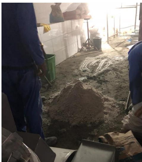
Figura 5: Preparação da argamassa
