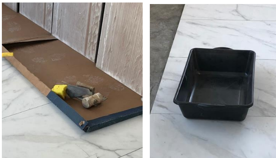
Figuras 1 e 2: Ferramentas utilizadas no assentamento
