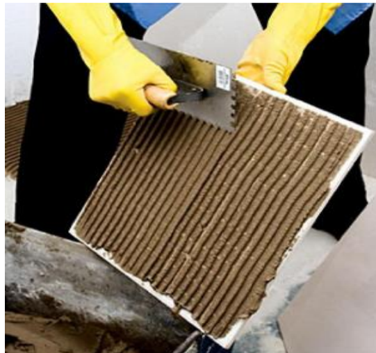
Figura 3 – Argamassa em toda extensão da peça
