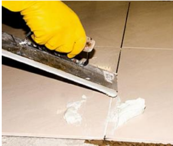
Figura 7 – Aplicação do rejunte nas peças Fonte: Construção Passo-a-Passo, 2009, p.102
