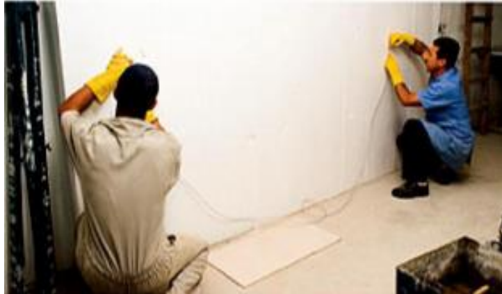
Figura 1 – Marcação com mangueira de nível
