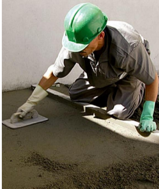
Figura 7 – Acabamento com Desempenadeira de Aço
