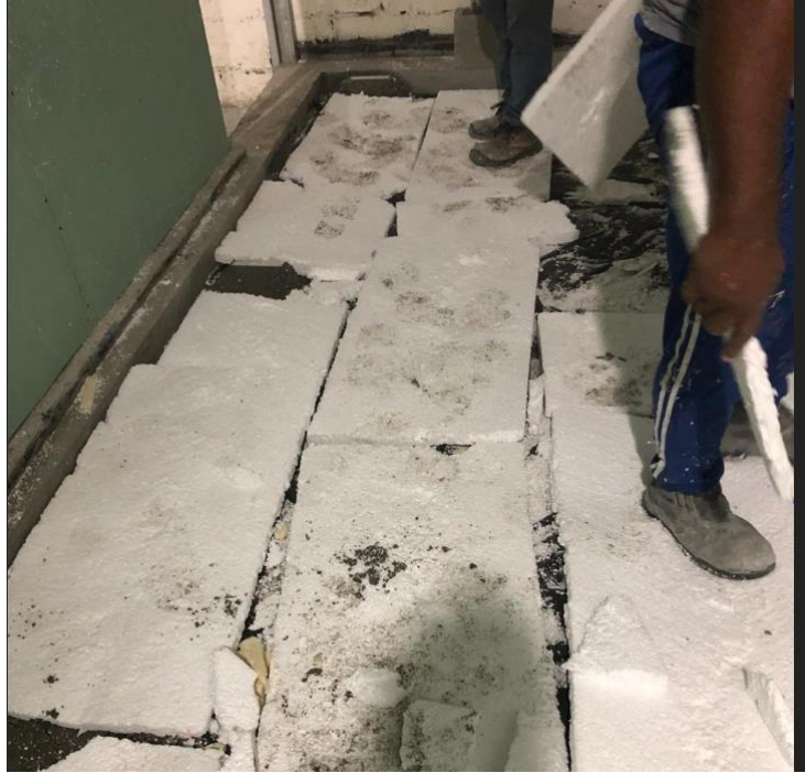
Figura 8: Utilização de Poliestireno (Isopor) no contrapiso
