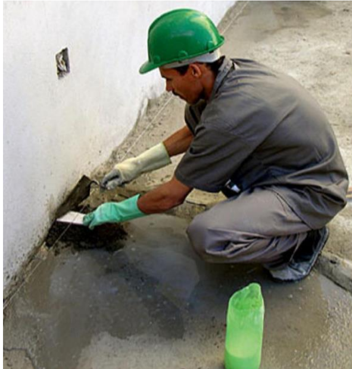
Figura 2 – Assentamento das Taliscas
