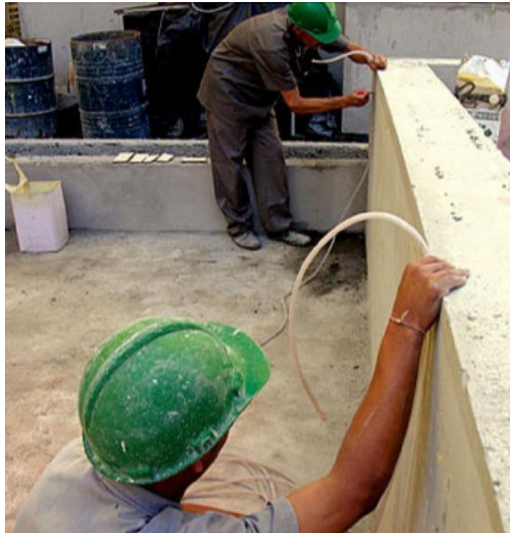
Figura 1 – Nivelamento do Contrapiso
