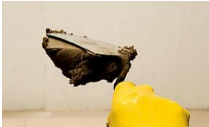
Figura 2 – Verificação do ponto da argamassa
