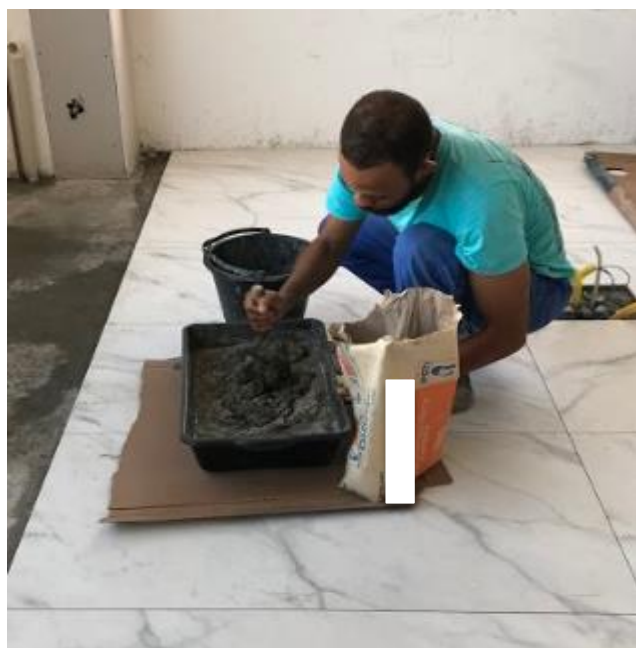
Figura 5: Preparação da argamassa
