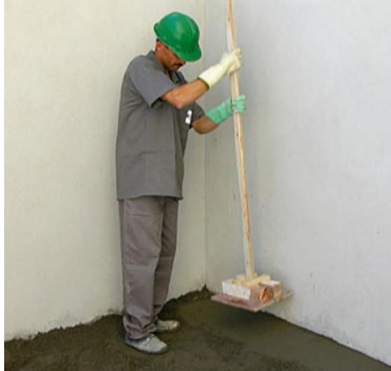
Figura 5 – Compactação da superfície
