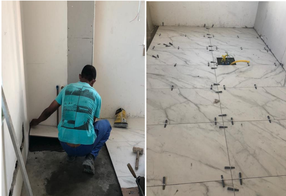
Figura 8: Assentamento do revestimento, espaçadores e cunhas niveladoras de piso
