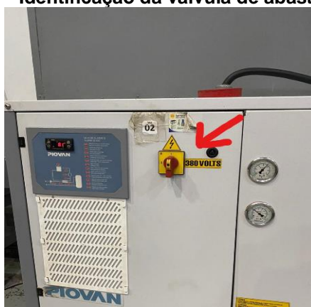
Figura 5 – Identificação da válvula de abastecimento
