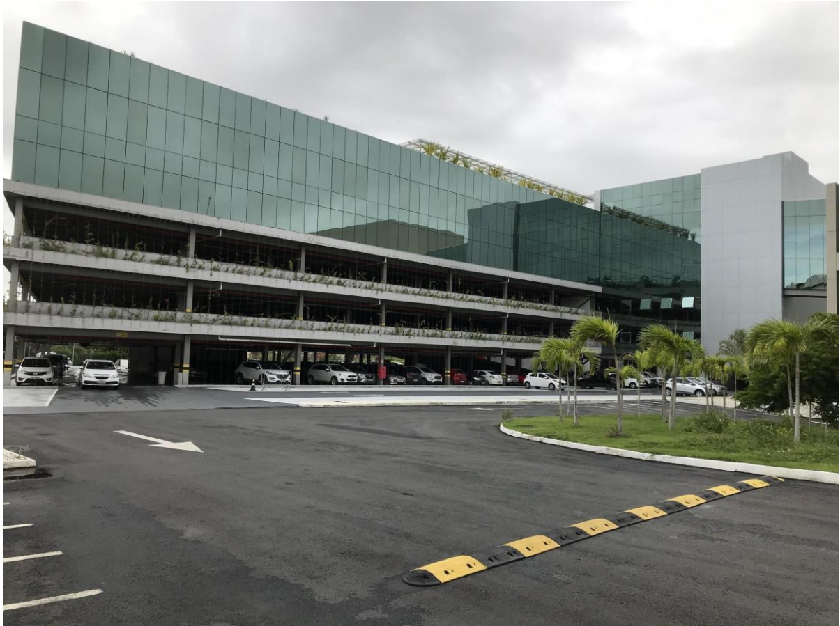
Figura 16: Vista Frontal Prédio Anexo II do TJ BA
