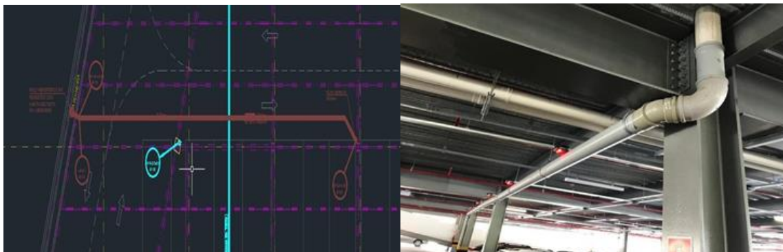
Imagem 3 – Tubulação de Água Pluvial
