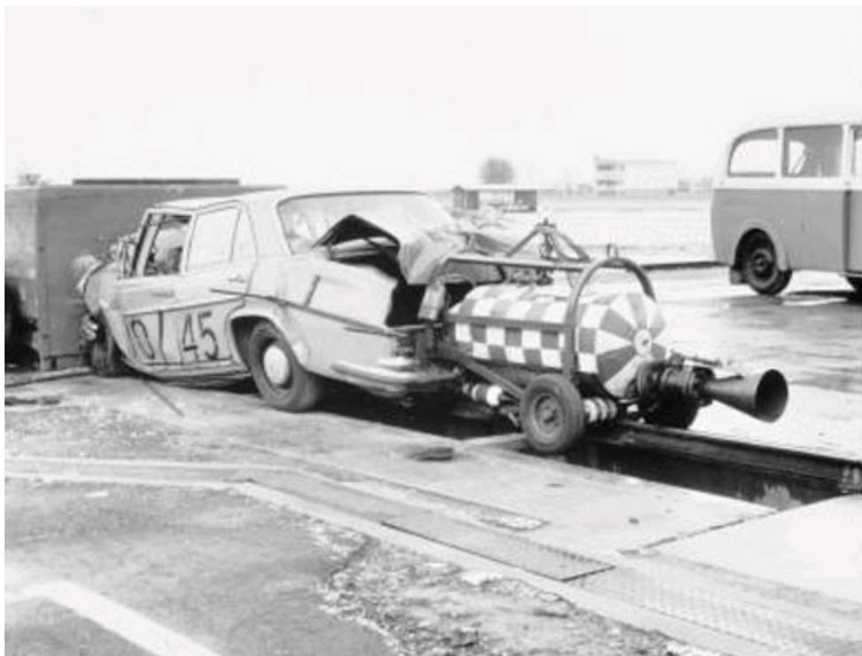
Figura 7 – Foguete de Impulsão da Mercedes-Benz, com o veículo colidido (MotorwayAmerica, 2011).
