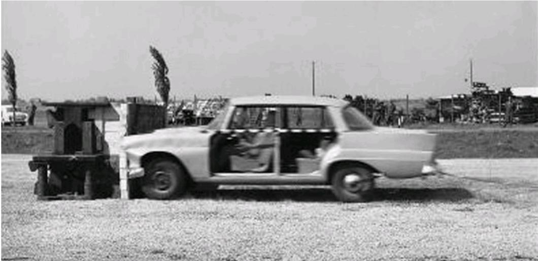
Figura 5 – Primeiro teste de impacto frontal da Mercedes-Benz, em 1959 (MotorwayAmerica, 2011).
