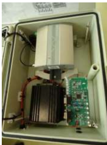
Figura 2 Vista interna da UTR FONTE: COELBA
