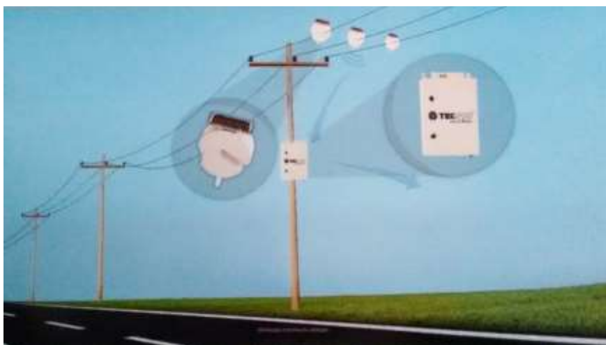
Figura 1 Conjunto de Sensores e UTR. FONTE: TECSYS
