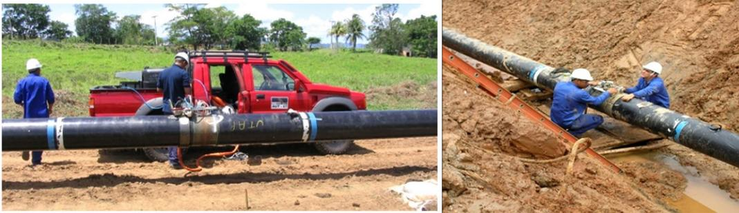
Figura 2. Inspeção phased array em dutos. (ANDREUCCI, 2002)
