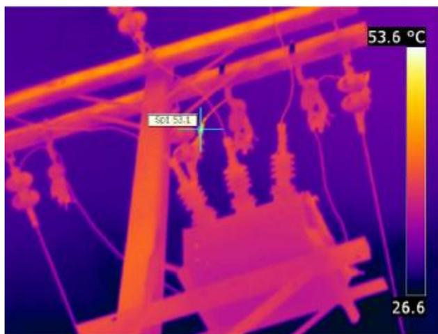
**Figura 4.13** Ponto quente na conexão da fase A chave a óleo
