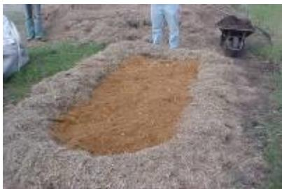
**Figura 05:** Aplicação da 2ª camada com maravalha ou serragem com espessura de aproximadamente 20 cm.
