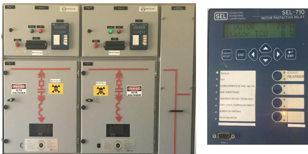
Figura 3 - Cubículo e Relé de proteção dos motores.
