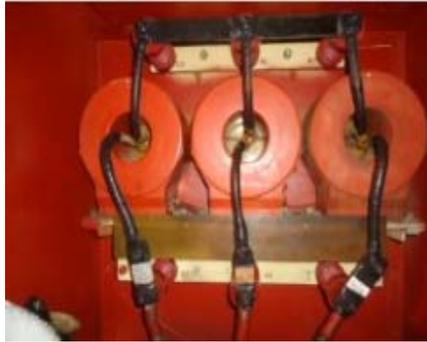
Figura 13 – Imagem interna da caixa de ligação do motor.
