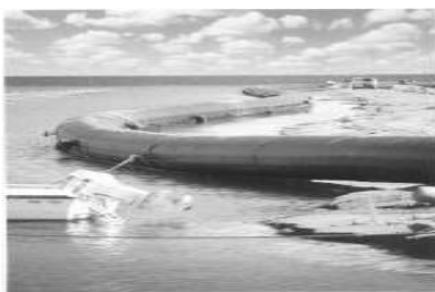
Figura 6 a) Assentamento sinuoso de tubos de PE
