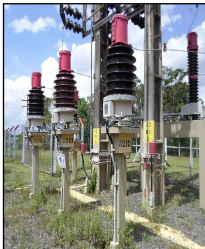
Figura 1: Transformador de Potencial.
