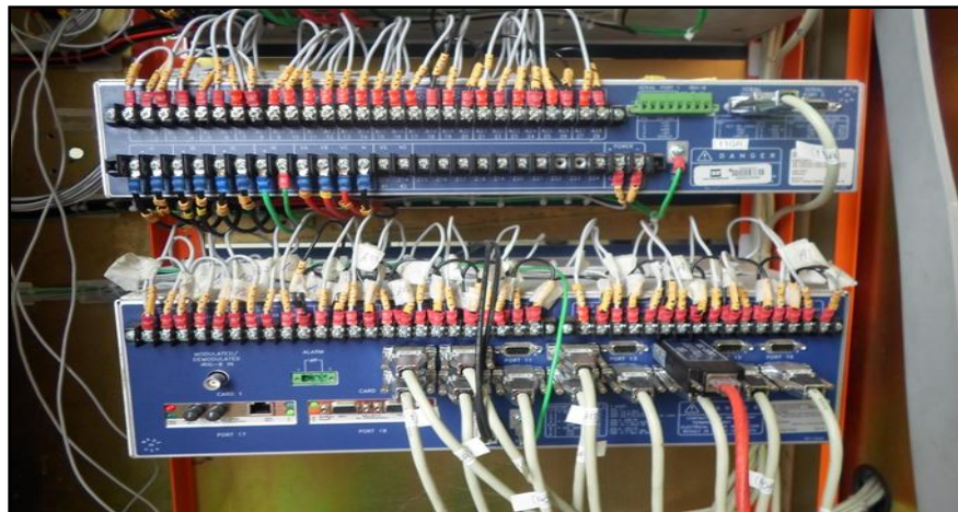
Figura 23: Cabos do secundário do Transformador de Corrente (TC) conectados ao relé.
