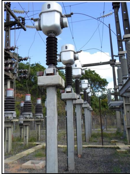
Figura 22: Transformador de Corrente (TC), conectado a rede primária.
