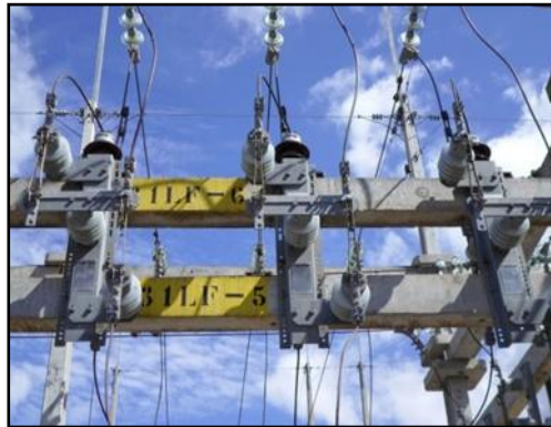
Figura 6: Chave Seccionadora.
