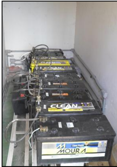
Figura 10: Banco de Baterias.
