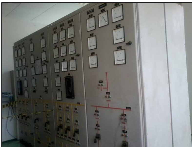
Figura 20: Painel com relés eletromecânicos.
