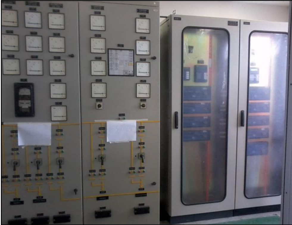
Figura 26: Painéis com relés eletromecânicos e numéricos.
