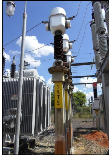
Figura 2: Transformador de Corrente.
