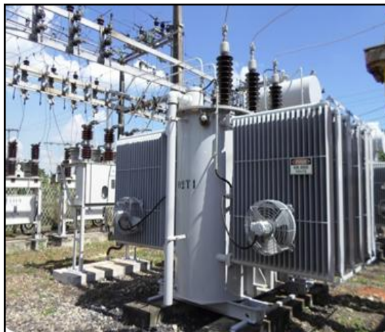
Figura 5: Transformador de Força.
