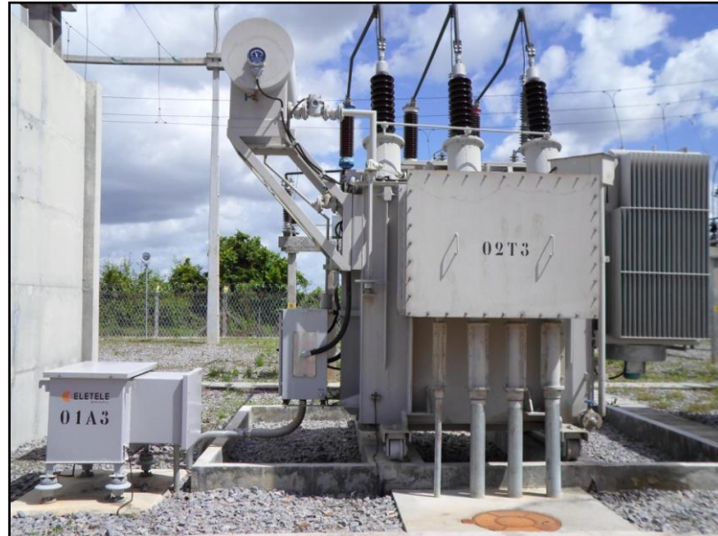
Figura 7: Resistor de Aterramento.
