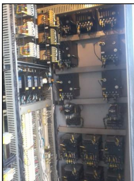
Figura 21: Vista interna do painel eletromecânico.
