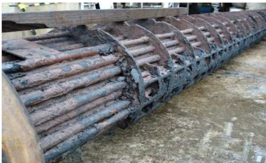
Figura 2 – Trocador de calor em manutenção (VALLE,2012).
